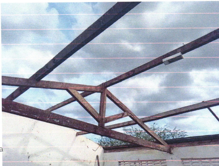
Foto 13 - Demolição de madeiramento em coberturas com telhas cerâmicas
