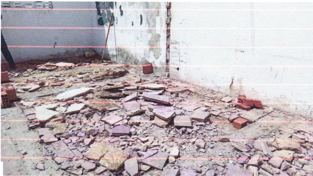
Foto 06 - Demolição manual de piso cimentado sobre lastro de concreto - Rev 01
