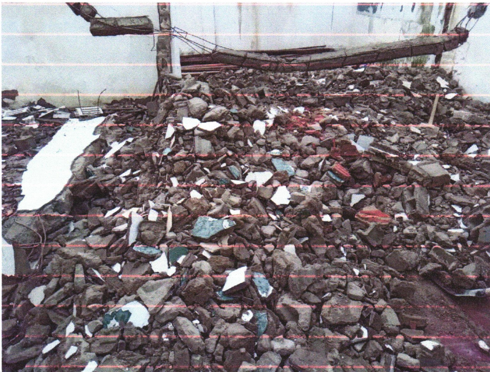
Foto 03 - DEMOLIÇÃO DE ALVENARIA DE BLOCO FURADO, DE FORMA MANUAL, SEM REAPROVEITAMENTO. AF_12/2017
