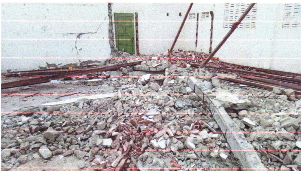
Foto 04 - DEMOLIÇÃO DE ALVENARIA DE BLOCO FURADO, DE FORMA MANUAL, SEM REAPROVEITAMENTO. AF_12/2017
