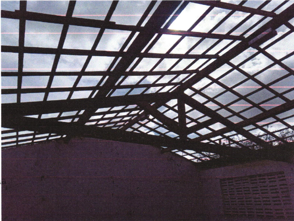
Foto 07 - Remoção de telhamento com telhas cerâmicas
