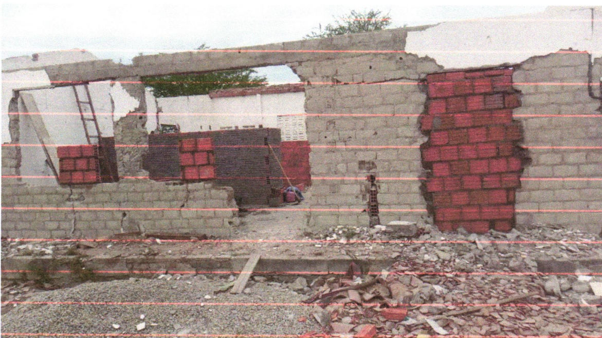
Foto 12 - ALVENARIA DE VEDAÇÃO DE BLOCOS CERÂMICOS FURADOS NA HORIZONTAL DE 9X19X29 CM (ESPESSURA 9 CM) E ARGAMASSA DE ASSENTAMENTO COM PREPARO EM BETONEIRA. AF_12/2021
