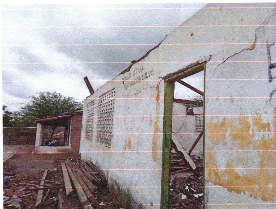
Foto 14 - Remoção de portas, de forma manual, sem reaproveitamento. af_12/2017
